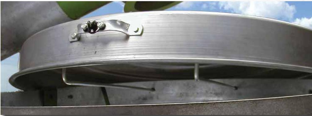
La tapa del orificio de relleno en forma de cúpula está montada sobre barras de acero para permitir que se deslice abierta y cerrada y evitar que sea lanzado alrededor en días de viento.
